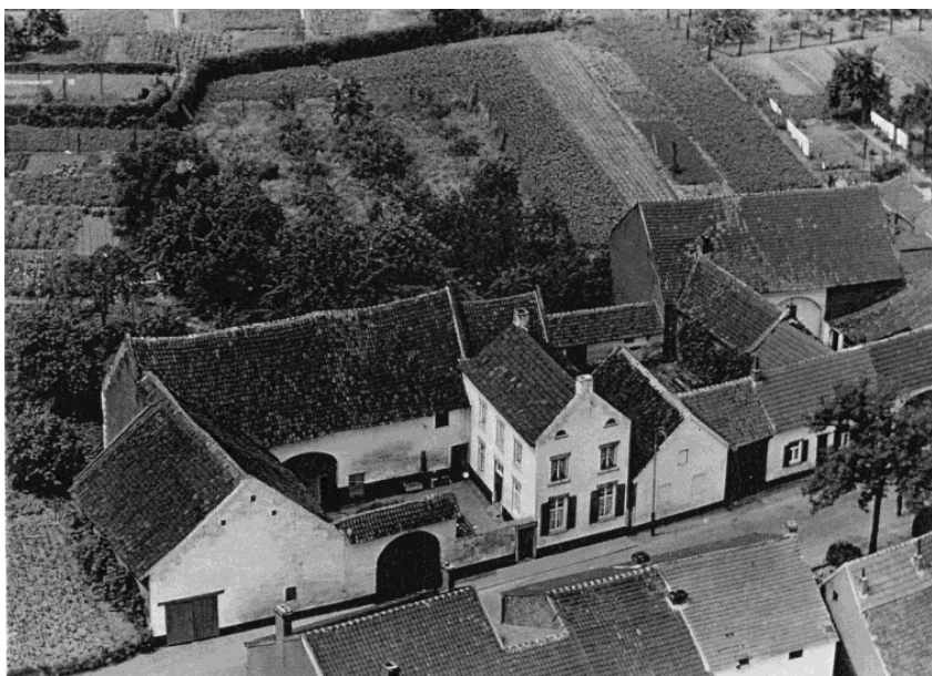
Voormalige Boerderij familie van den Boorn, nadien garage van den Boorn aan de Heugemerstraat. Nu verbouwd tot complex van Radar.
